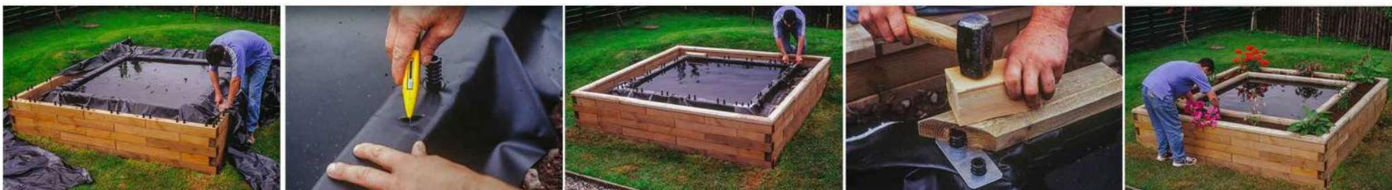
Pour la construction de bassins, il est recommandé de tapisser le fond de la structure avec de la moquette ou du sable pour se débarrasser des angles vifs qui peuvent entrainer un amas d'impuretés . Assurez-vous ensuite que le liner est fixé au dessus des chevilles en faisant une incision en croix pour leur permettre de passer à travers. Pour finir, ajoutez la rangée de modules de finition supérieure.
