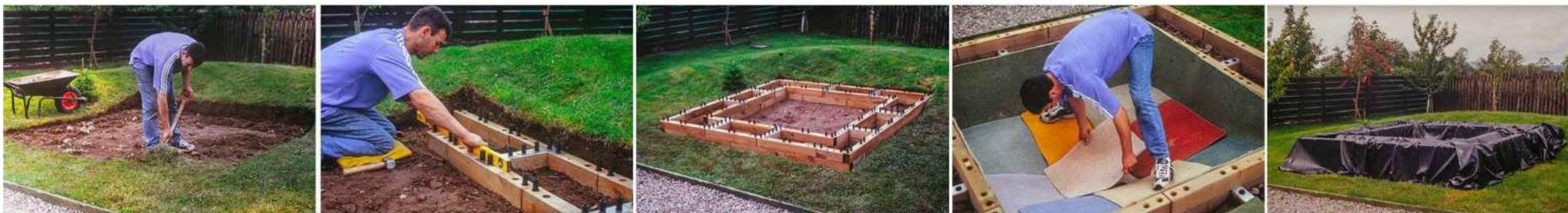
L'élément clé de la construction de nos bassins est d'obtenir des fondations bien plats avant de démarrer. Cela vous permettra de monter les rangées de blocs facilement en suivant les instructions propre à votre modèle.
